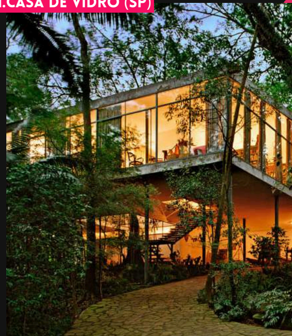
1.CASA DE VIDRO (SP)
